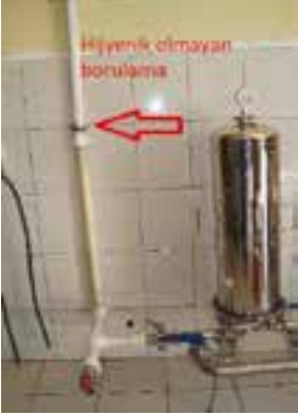
Resim 10: Hijyenik olmayan borulama.
